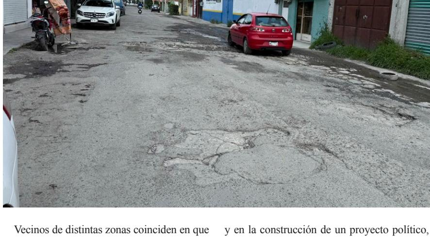
Vecinos de distintas zonas coinciden en que las labores de bacheo se realizaron sin retirar el asfalto dañado, sin compactación adecuada y sin materiales de calidad, lo que derivó en soluciones temporales que no resistieron el uso diario ni las condiciones climatológicas.
