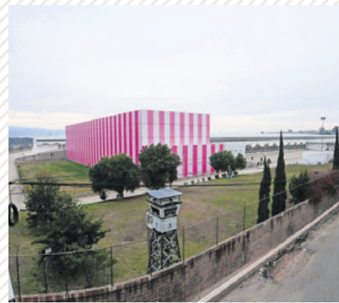
Las instalaciones pertenecieron anteriormente a la tienda departamental Liverpool.
